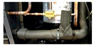
Prüfen Sie, ob das Kabel des Magnetventils nicht zu nah am Kompressor verläuft.
