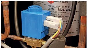
**6.** Prüfen Sie, ob das Kapillarrohr des Thermoventils mit einer Isolierung und Kabelbindern wie gezeigt gesichert ist.
